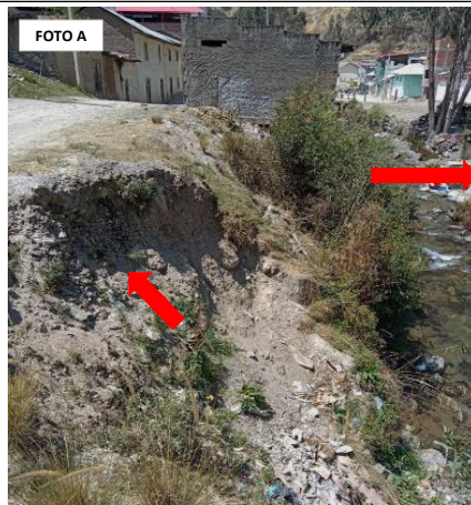
FIGURA N°02: SE OBSERVA SEGUN LA FOTO (A) QUE EL CAUCE CENTRAL ESTA COLMATADO Y ESTRANGULADO REQUIERE LIMPIEZA Y QUE SE CONFORME UNA CAJA HIDRAULICA FUNCIONAL FRENTE A LAS MAXIMAS AVENIDAS EN EPOCAS DE INVIERNO ASI MISMO EN LA FOT (B) SE OBSERVA QUE EN ALGUNOS SECTORES HAY DESMONTE QUE OBSTACULIZA EL FLUJO NORMAL DEL AGUA.
