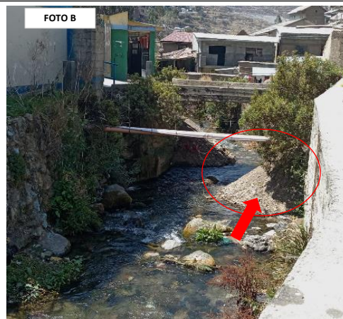
FIGURA N°02: SE OBSERVA SEGUN LA FOTO (A) QUE EL CAUCE CENTRAL ESTA COLMATADO Y ESTRANGULADO REQUIERE LIMPIEZA Y QUE SE CONFORME UNA CAJA HIDRAULICA FUNCIONAL FRENTE A LAS MAXIMAS AVENIDAS EN EPOCAS DE INVIERNO ASI MISMO EN LA FOT (B) SE OBSERVA QUE EN ALGUNOS SECTORES HAY DESMONTE QUE OBSTACULIZA EL FLUJO NORMAL DEL AGUA.
